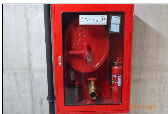
รูปที่ 2-71 ตู้เก็บสายฉีดน้ำดับเพลิงพร้อมอุปกรณ์ (Fire House Cabinet: FHC) ติดตั้งถังดับเพลิง คาร์บอนไดออกไซด์แบบมือถือ ไว้บริเวณห้องเครื่องไฟฟ้า
